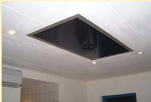
Infrarotheizung Montage an der Decke
